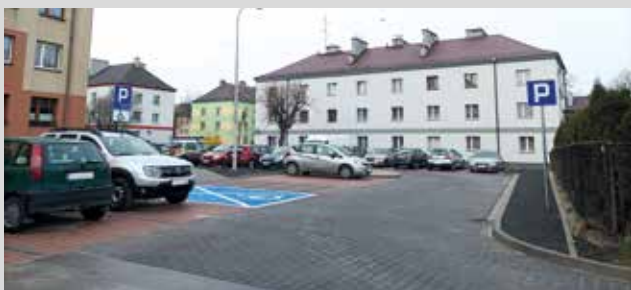
Wjazd na parking przed i po przebudowie.
