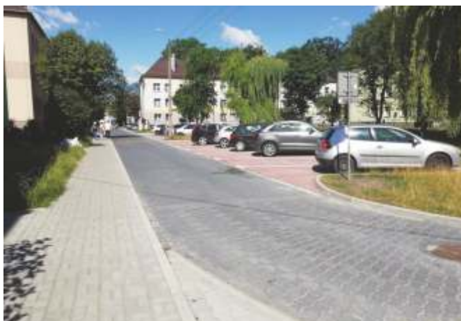
W ramach zadania zmodernizowano drogi osiedlowe o długości ok. 430 m, przebudowano 60 miejsc parkingowych i posadzono 22 drzewa.
