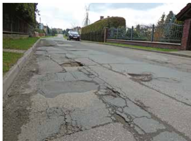
Ul. Grunwaldzka przed inwestycją.
