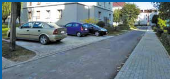
Remont układu drogowego w rejonie ulic: 1 Maja, Konopnickiej oraz Żwirki i Wigury w Brzeszczach, 2023 rok.
