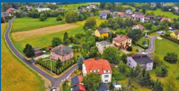
Remont ulic Zagrodowa i Młynarska w Wilczkowicach 2022 rok.
