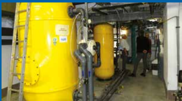
Wymiana złożeń filtracyjnych dla filtra stacji uzdatniania wody „Basenu pod Platanem” w Brzeszczach, 2021 rok (wartość inwestycji: 154 tysiące złotych).
