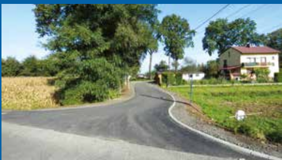
Przebudowa ul. Piwnej w Skidziniu, 2023 rok.
