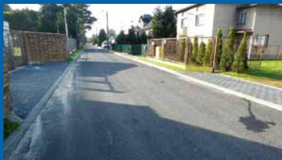
Remont ul. Wyszyńskiego w Jawiszowicach, 2023 rok.
