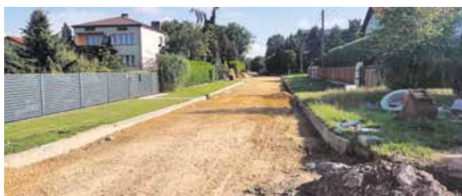
Ul. Grunwaldzka w trakcie remontu
