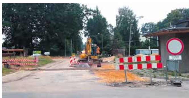
Ul. Daszyńskiego w trakcie remontu
