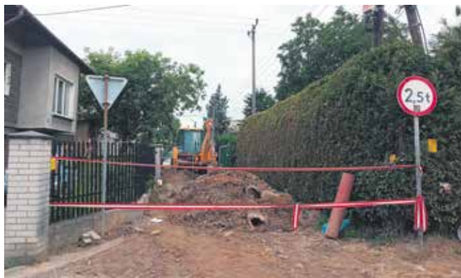
Ul. Pańska w trakcie remontu
