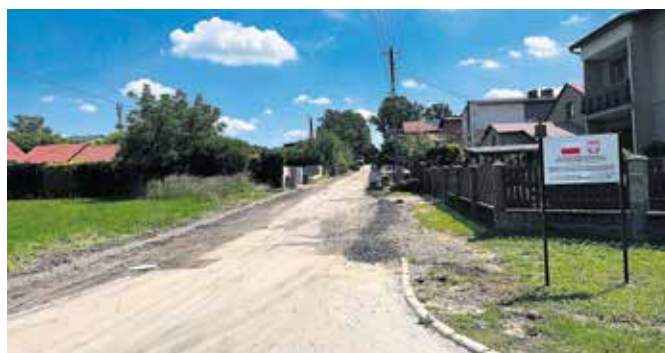
Ul. Popiełuszki w trakcie remontu
