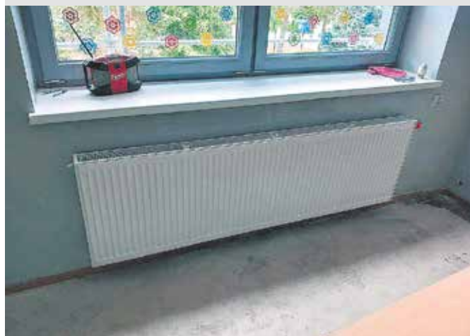
Zlikwidowane zostały stare piece węglowe. W budynku wykonano nową instalację centralnego ogrzewania.
