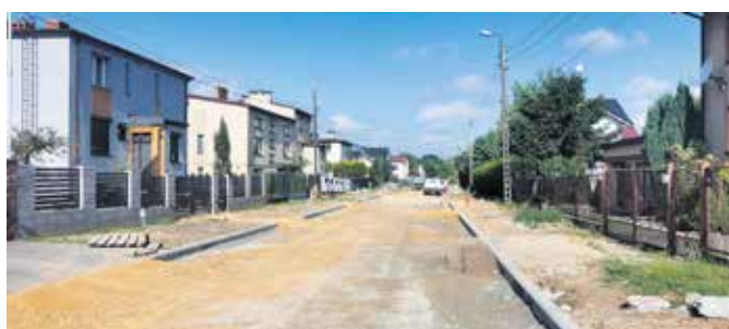
Ul. Grottgera w trakcie remontu
