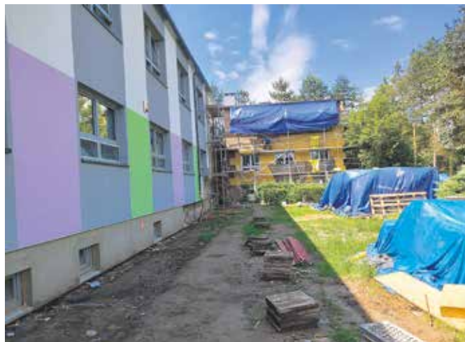
Roboty termomodernizacyjne w budynku w Zasolu obejmują m.in. docieplenie ścian zewnętrznych oraz wykonanie nowej elewacji.
