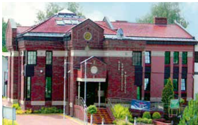
Bank Spółdzielczy w Miedźnej, ul. Wiejska 2, 43-227 Miedźna.
