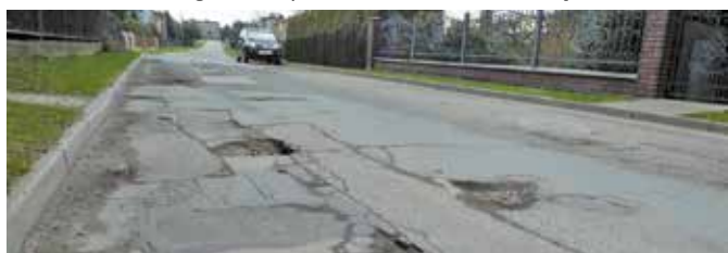
Ul. Grunwaldzka przed remontem.
