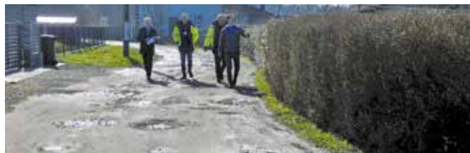
Ul. Pankowicka przed remontem.
