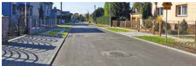
Ul. Grottgera po remoncie.
