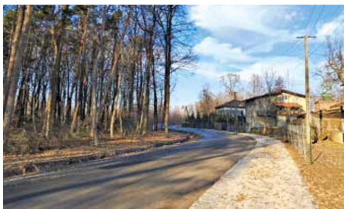
Przebudowa ul. Borowej zakończona.
