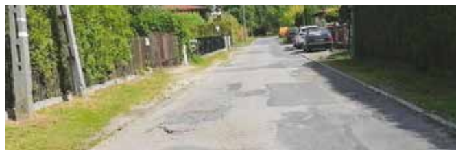
Ul. Pańska przed remontem.
