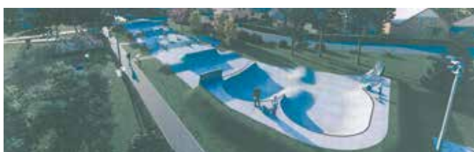
Skatepark o powierzchni 650 m kw. wykonany zostanie w technologii betonowej monolitycznej. Zadanie realizuje będzie Firma Techramps sp. z o.o., zajmująca się budową profesjonalnych placów do jazdy na rolkach i deskorolkach.
